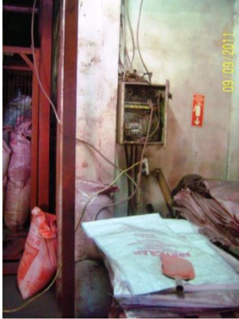
Resim 15- Panoya bağlı uzatma kabloları
