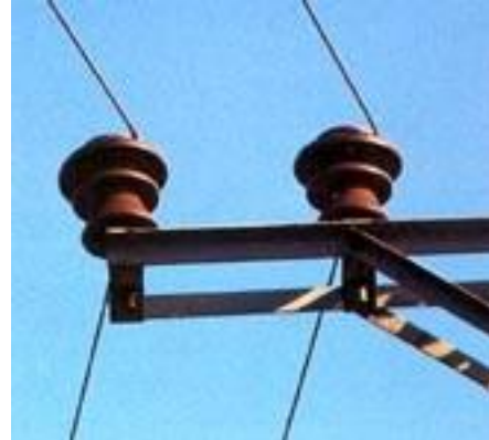
Resim 46- Mesnet tipi izolatörler
