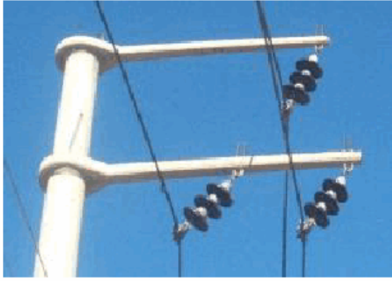
Resim 45- Zincir tipi porselen izolatörler
