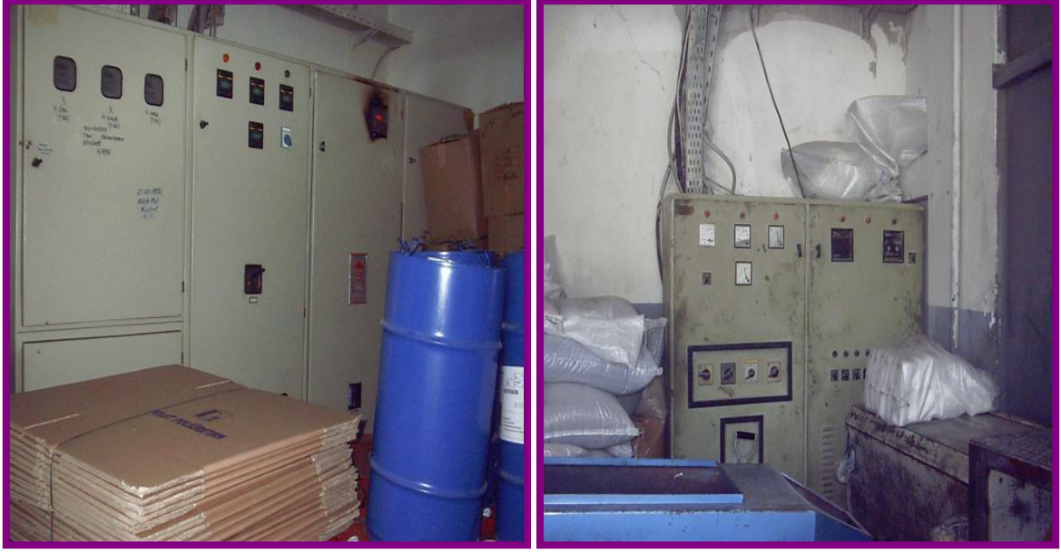
Resim 29-30 Pano yakınında engelleyici ve yanıcı madde bulundurulması
