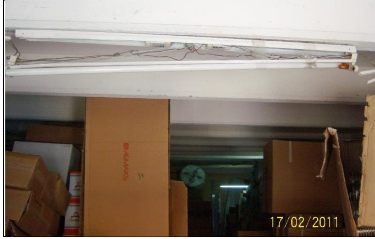
Resim 7- Soketinden çıkmış fluoressan lamba
