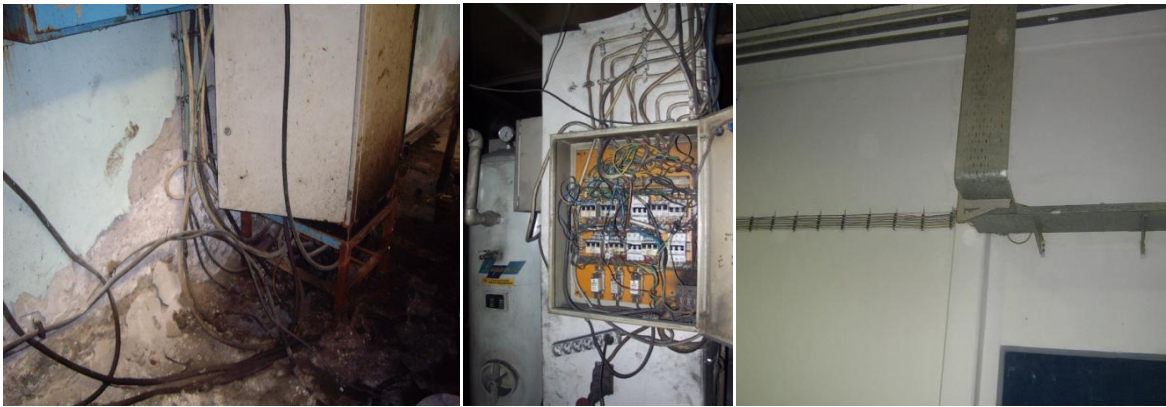
Resim 13- Düzensiz kablolama görüntüleri
