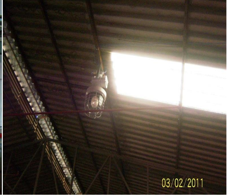
Resim 18- Ex-proof aydınlatma armatürü
